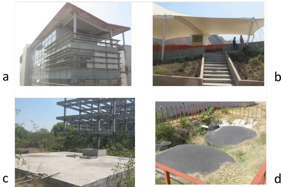
Figura 4. Sistema de captación de agua en la UACM plantel San Lorenzo. Cuenta con infraestructura moderna. Los edificios tienen una forma adaptada a la captación de lluvia (b). Otras estructuras han sido utilizadas como superficie de captación, como el auditorio (a). Un pozo denominado “de tormenta” re-infiltra el agua de lluvia que no es utilizada, al acuífero (d). Tanques con una capacidad total de 3000, 000 litros, almacenan toda el agua de lluvia (c).
