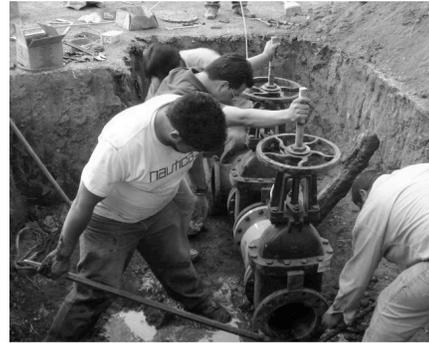
**Figura 3.** Instalación de medidores electromagnéticos en los Pozos.
