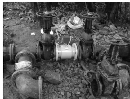
**Figura 4.** Instalación de medidores electromagnéticos en Sectores Hidráulicos
