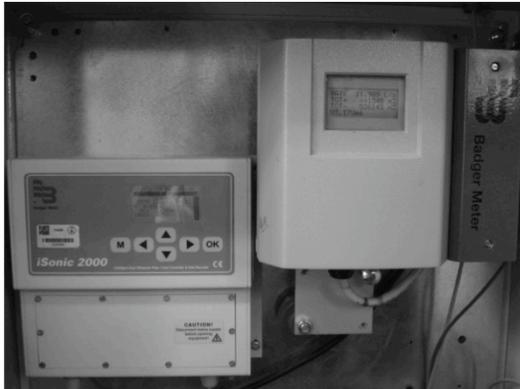
**Figura 5.** Instalación de sensores de nivel en los Tanques de Regulación.
