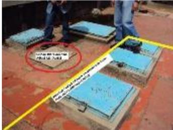
*Ilustración 18. Caja de aguas residuales junto a tanque*
