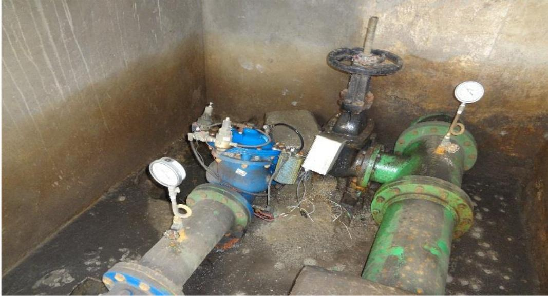
*Ilustración 32. Válvula reguladora de presión instalada en el sector III*
