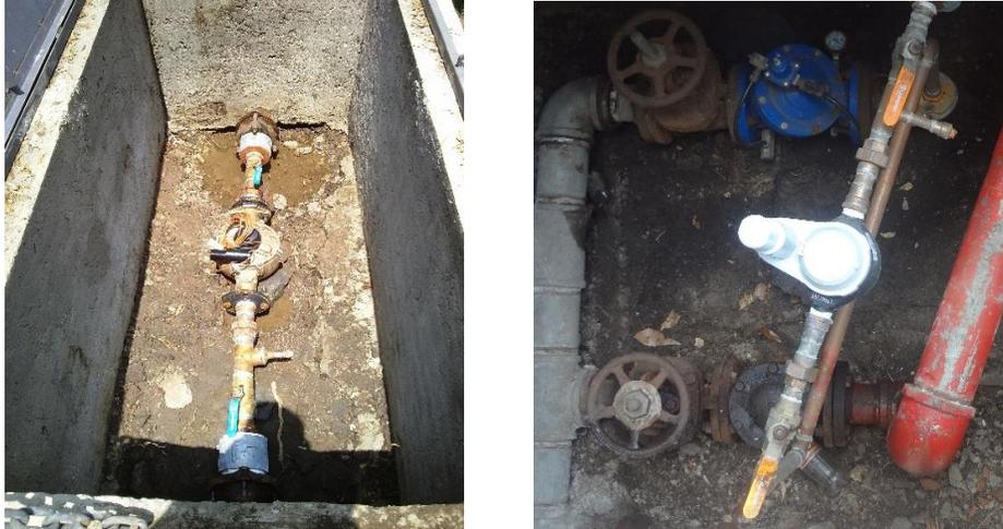
*Figura 1. Micro medidores instalados en dependencias universitarias*
