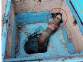
*Ilustración 23. Falta de recubrimiento en tubos enterrados que atraviesan las paredes del tanque*
