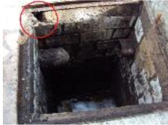
*Ilustración 19. Caja de inspección de aguas residuales*
