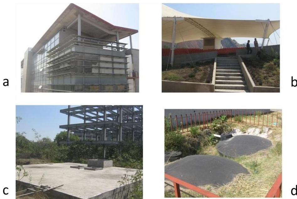
Figura 30. Sistema de captación de agua en la UACM plantel San Lorenzo. Cuenta con infraestructura moderna. Los edificios tienen una forma adaptada a la captación de lluvia (b). Otras estructuras han sido utilizadas como superficie de captación, como el auditorio (a). Un pozo denominado “de tormenta” re-infiltra el agua de lluvia que no es utilizada, al acuífero (d). Tanques con una capacidad total de 3000,000 litros, almacenan toda el agua de lluvia (c).
