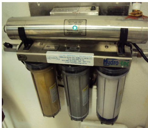
Dispositivo de tratamiento de tipo doméstico en tres etapas
