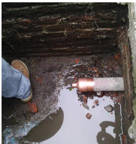
Figura 22. Reducción tipo Bushing para tuberías de cobre.
