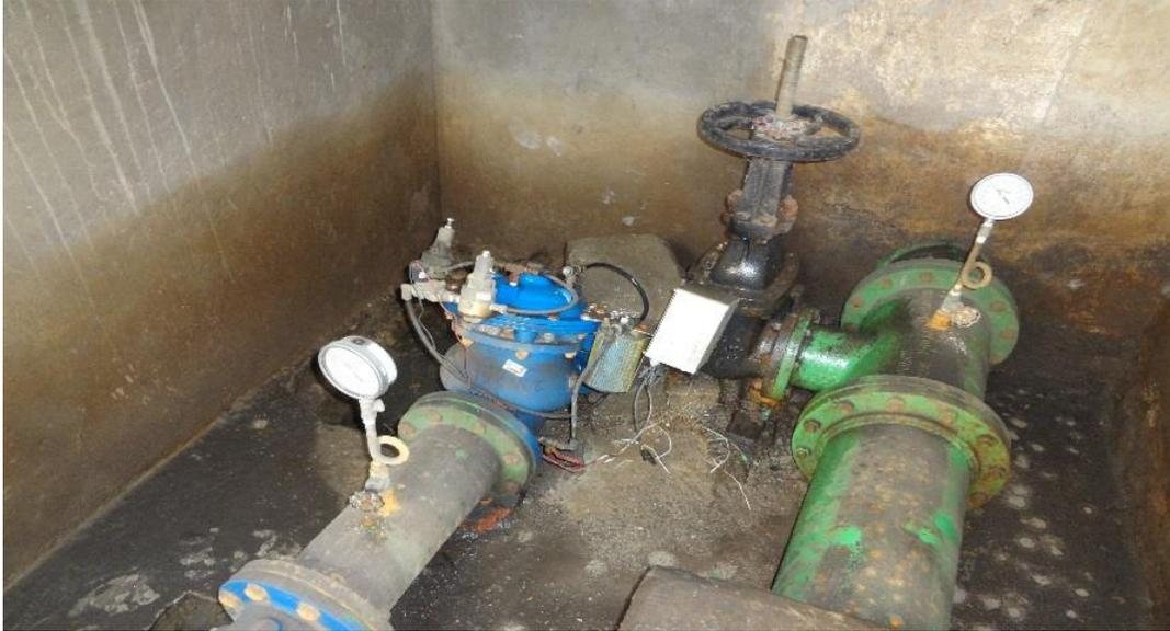
*Figura 11. Válvula reguladora de presión instalada en el sector III*
