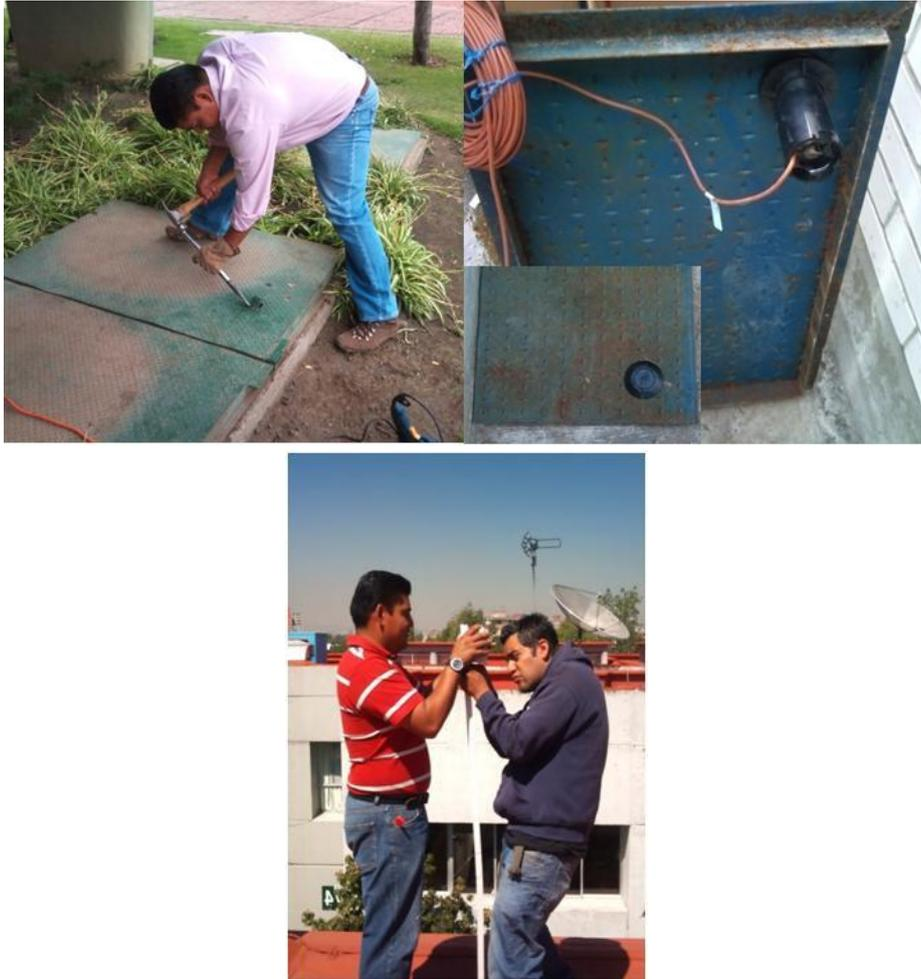
Figura 4. Trabajos de perforación de tapas metálicas para facilitar el enlace de los medidores a los equipos receptores de señal o Gateway.
