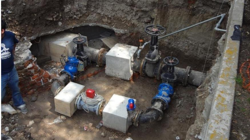
**Figura 2. Medidor electromagnético y válvula reguladora de presión correspondientes al sector hidráulico 1 instalado durante 2012.**
