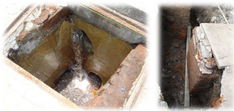
Figura 1. Trabajos de eliminación de fugas en el campus de CU. UNAM
