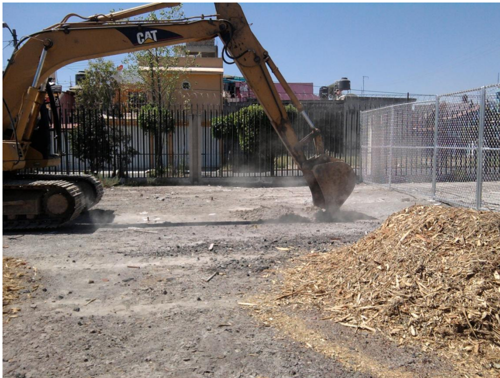
Figura 3. Elaboración de cepas con la retroexcavadora.
