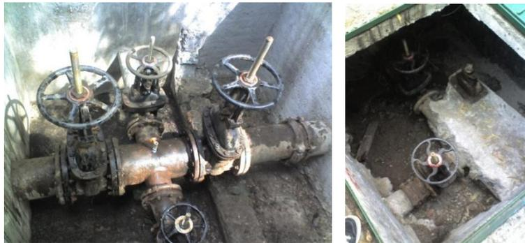
*Figura 10.* Cruceros de la red de distribución de agua potable. Línea de 10” con derivaciones a 4”.
