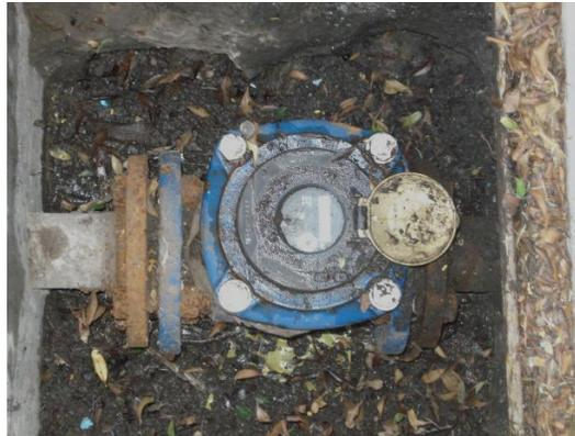
Figura 12. Medidor de 2”, encontrado en la zona de Rectoría, el cual no funciona.
