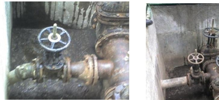
*Figura 11.* Reducción de diámetros en la red. Izquierda: Reducción campana. Derecha: Tee reductora.
